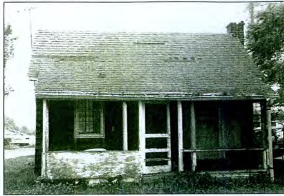
Figure 5-88: Mullikin Tenant Farm (T-390) Tenant House
